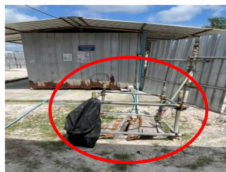
รูปที่ 3-34 ระบบบำบัดน้ำเสียสำเร็จรูป
